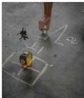
4 Headrigger bei der Arbeitsvorbereitung und Detailplanung
